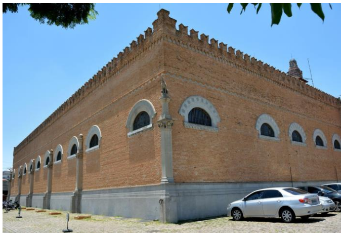
Parede externa do Claustro
