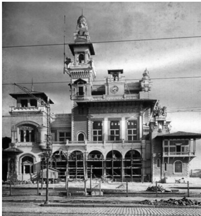
Figura 1: Processo de construção do Palácio das Indústrias
